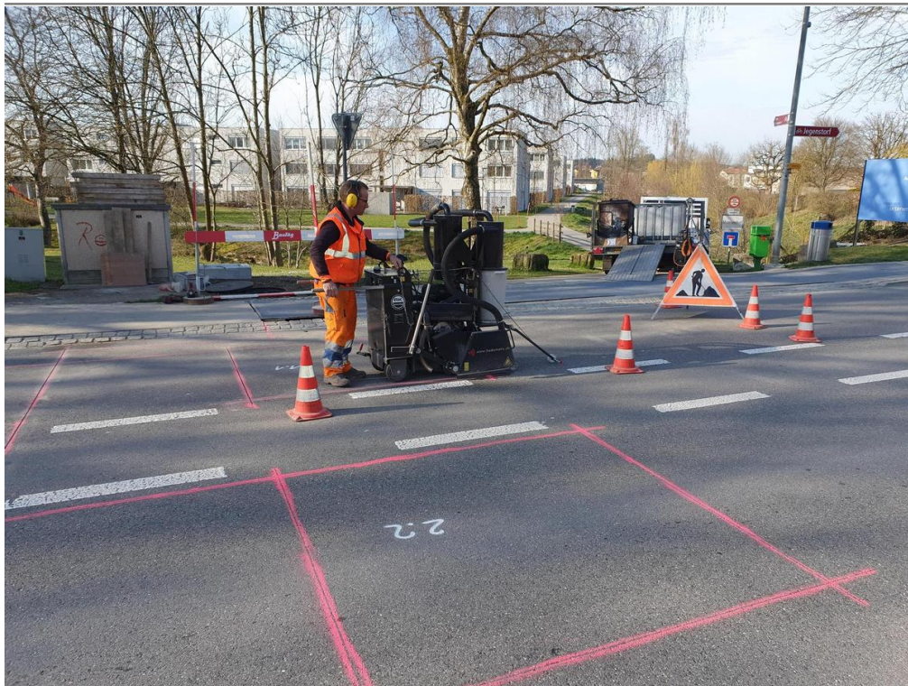
Im letzten Frühling wurden die Zählstellen in der Fahrbahn eingelassen. Foto: zvg/Tiefbauamt Kanton Bern
