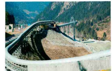
■ Die Bewältigung des Ausbruchmaterials der zweiten Röhre Gotthard-Strassentunnel im Gesamtbauwerk von 7,4 Mio. t stellt eine gewaltige logistische Aufgabe dar. Dafür werden umfangreiche Anlagen mit Förderbändern, Bahnwaggons und Lastwagen auf beiden Portalseiten eingesetzt. (Bild: Astra)
