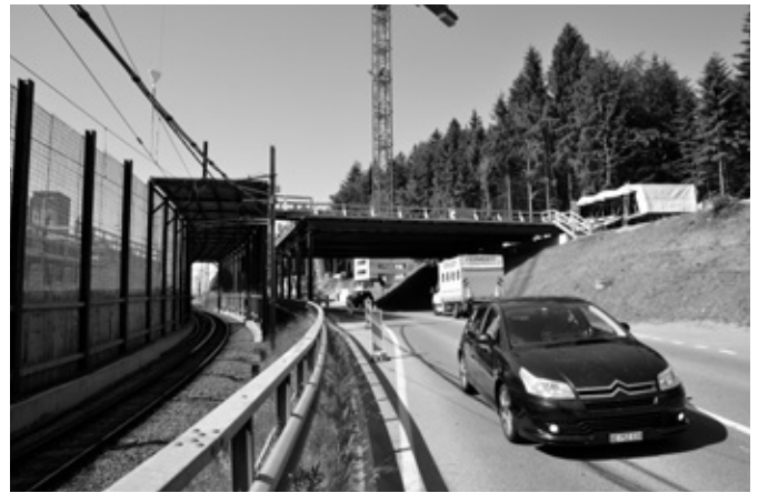
Die Schutztunnels über Schiene und Strasse ermöglichen gefahrlose Kranarbeit
