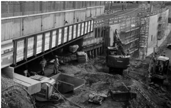
Nachdem die Hilfsbrücke versetzt ist, beginnt darunter der Abtrag des Erdreichs. (Bild: vistaplus, Peter Burri)
