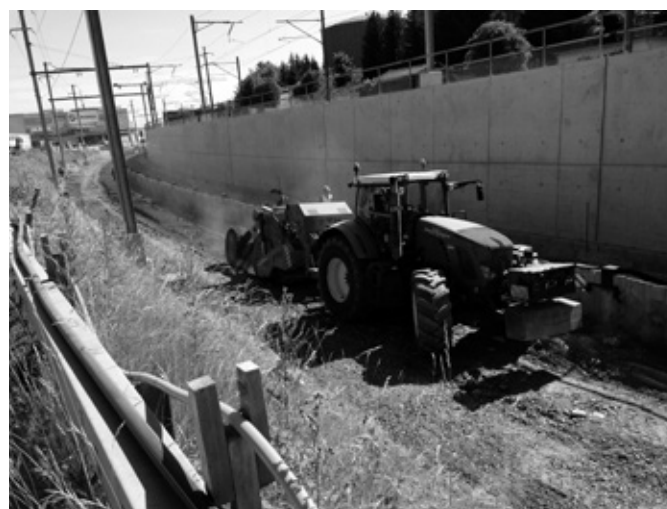
Abtrag der Foundationsschicht auf dem alten Trasse
