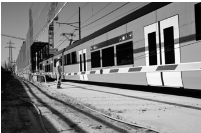
Ein Bahnübergang mit Vollschränken sichert die Zufahrt zur Baustelle zwischen SBB- und RBS-Gleis
