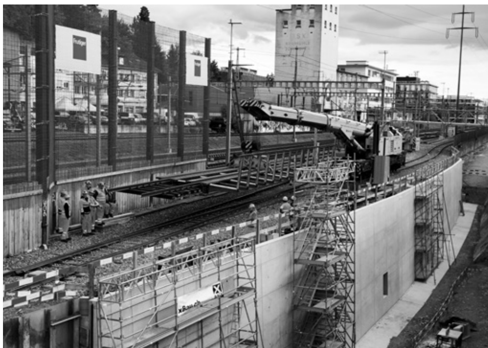
Einbau der ersten Hilfsbrücke mit dem SBB-Kirow-Kran
