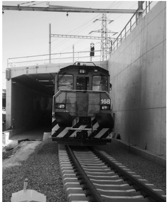
Mit dem RBS-Bauzug wird das neue Bahngleis verlegt, Hauptschotterung und Fahrleitung folgen
