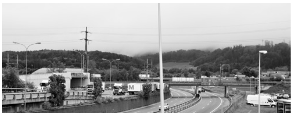
Die Rampe für die LKW-Brücke neben der SBB ist links schon betoniert
