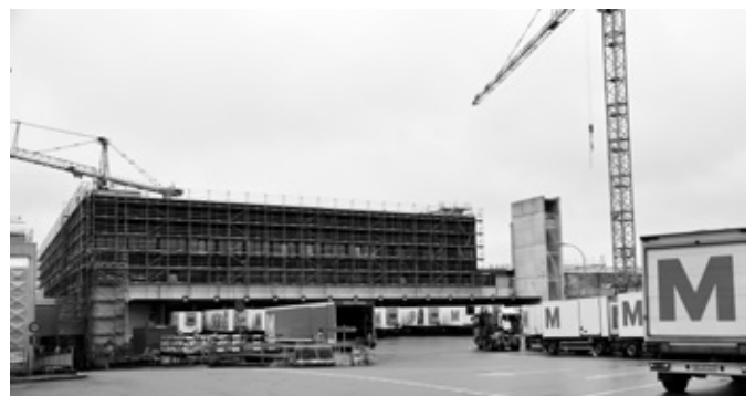
Die Betriebszentrale DELTA ist noch im Bau, aber im Inneren laufen schon Teile der Logistik
