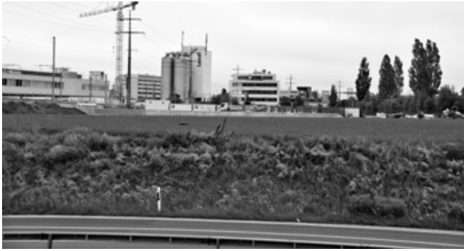
Die Landreserve zwischen SBB und Autobahn A1 ist bereits mit einem Tunnel unter der SBB erschlossen und dient aktuell für die Bau- und ab Juni 2020 für die Transportlogistik
