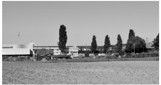
Die BZ4 wird den Platz des heutigen «Schaerer-Gebäudes» einnehmen. (Blick vom Moosbühl)
