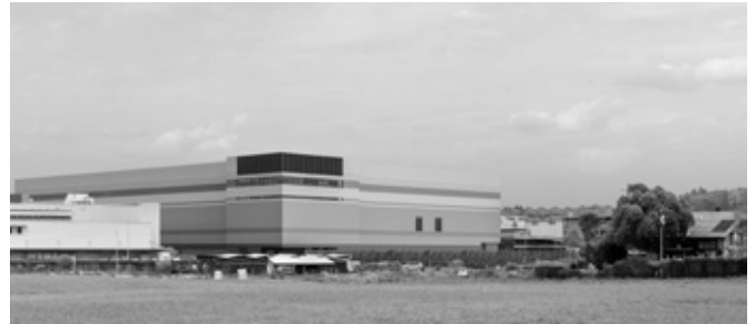
Die Betriebszentrale BZ4 ist ein kompletter Neubau (Bild: Migros; Blick vom Moosbühl)
