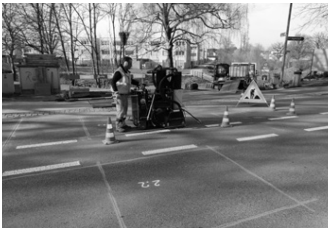
Schritt 1: In den Strassenbelag werden Schlitze gefräst
