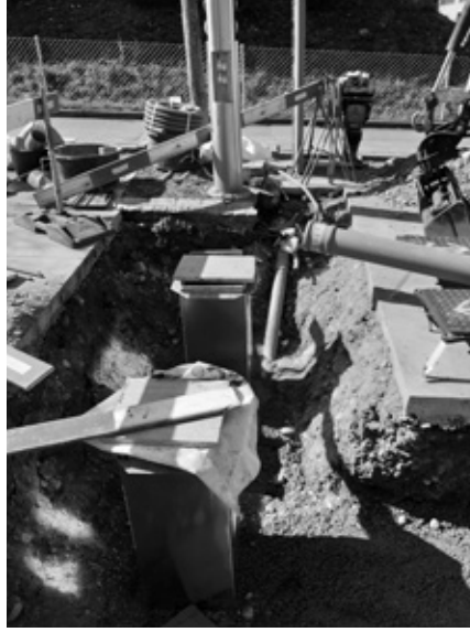
Die neuen Poller sind gesetzt
