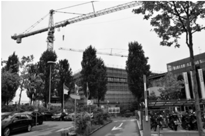
Bei der Anreise zum Shoppyland stehen die grossen Baukräne ins Auge. Sie dienen dem Um- und Ausbau der Betriebszentrale DELTA
