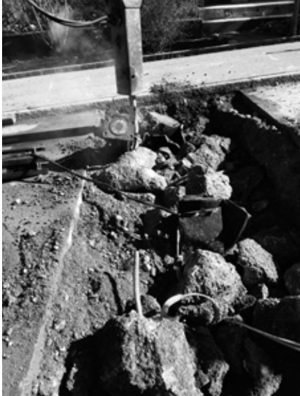
Ausbruch der alten Anlage
