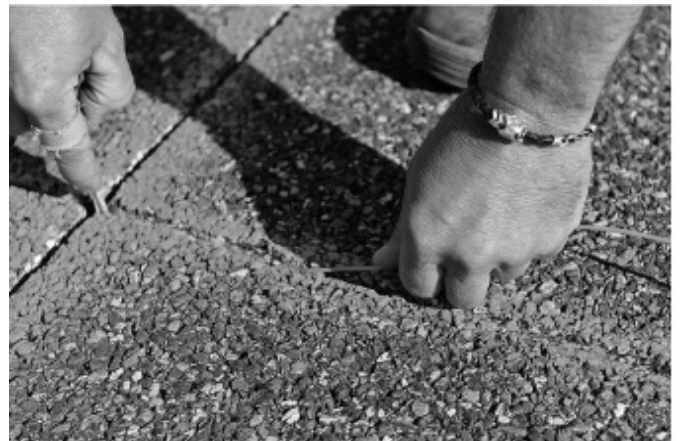
Schritt 2: In die Schlitze wird Kupferdraht eingelegt. Es braucht pro Schleife vier Windungen, damit ein Magnetfeld entsteht
