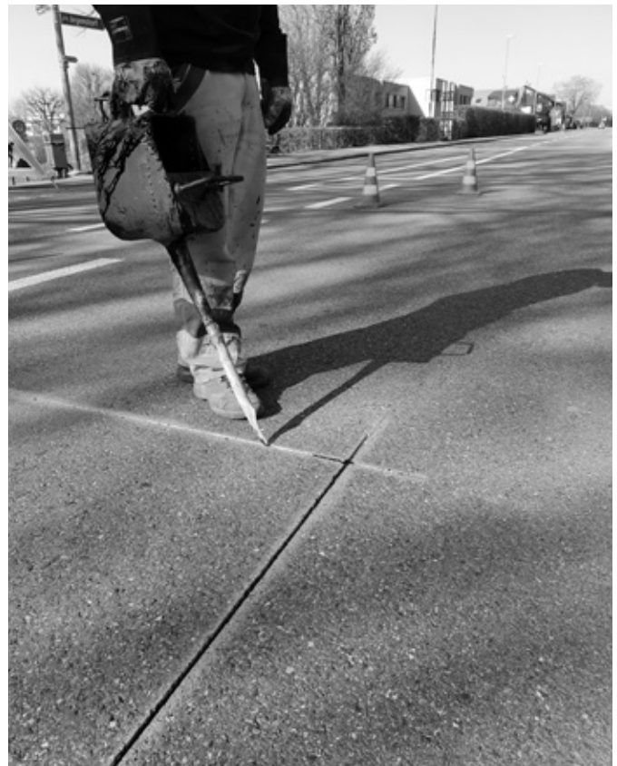
Schritt 3: Die Schlitze werden mit heissem Bitumen wieder vergossen. (Bilder: Hadomatic)
