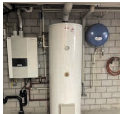
Alte Gasheizung und Boiler
