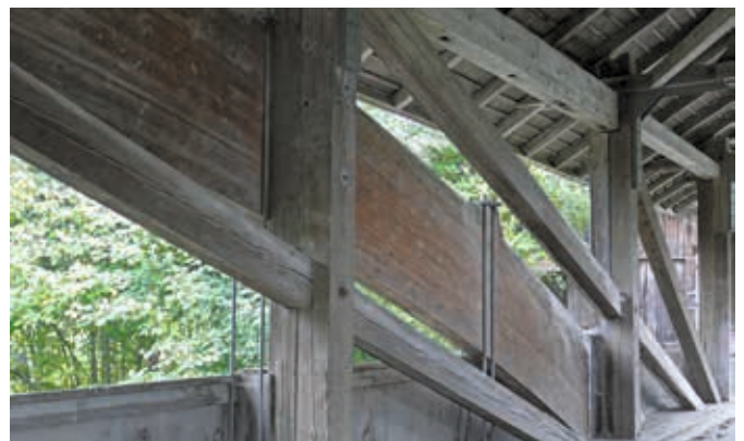
Dieboldswil-Holzbrücke, Tragfähigkeit von 5 auf 24 t erhöht.
