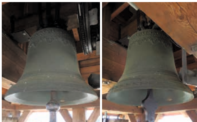
Kleinste Glocke mit herkömmlichem Klöppel vorher (links) und neuem Flügelklöppel (rechts)
