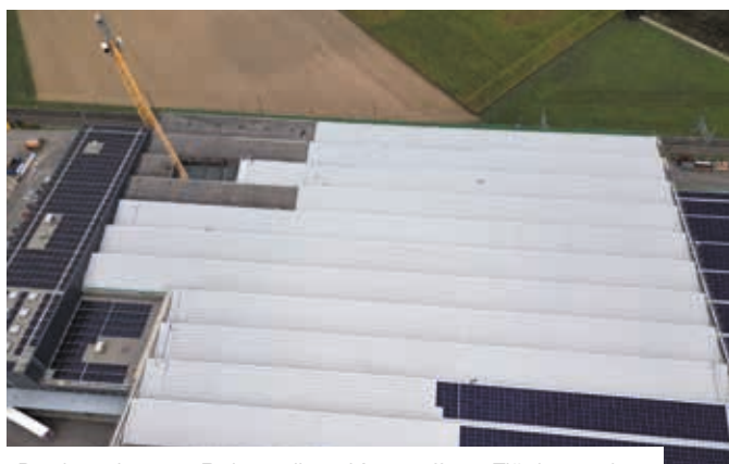
Dachsanierung: Beim gelben Kran: offene Fläche und altes Eternit; vorne Trapezblech, Verkabelung und erste Solarmodule.
